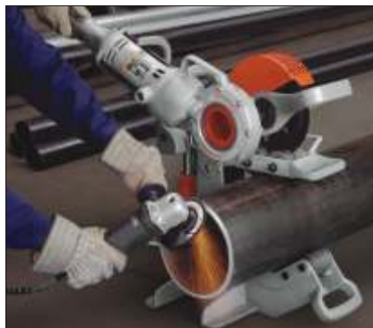
Modelo 258 usando o Rolo para biselar tubos. Dois operadores são recomendados nesta operação.
