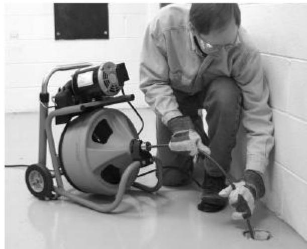
Figura 12 - Na posição de operação - inserção manual do cabo
