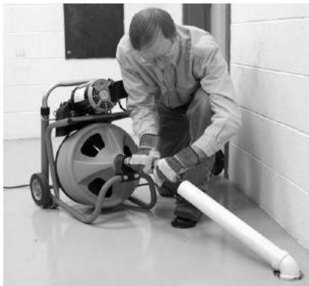
**Figura 9 – Exemplo de extensão de dreno para até 0,6 m da abertura do dreno**
